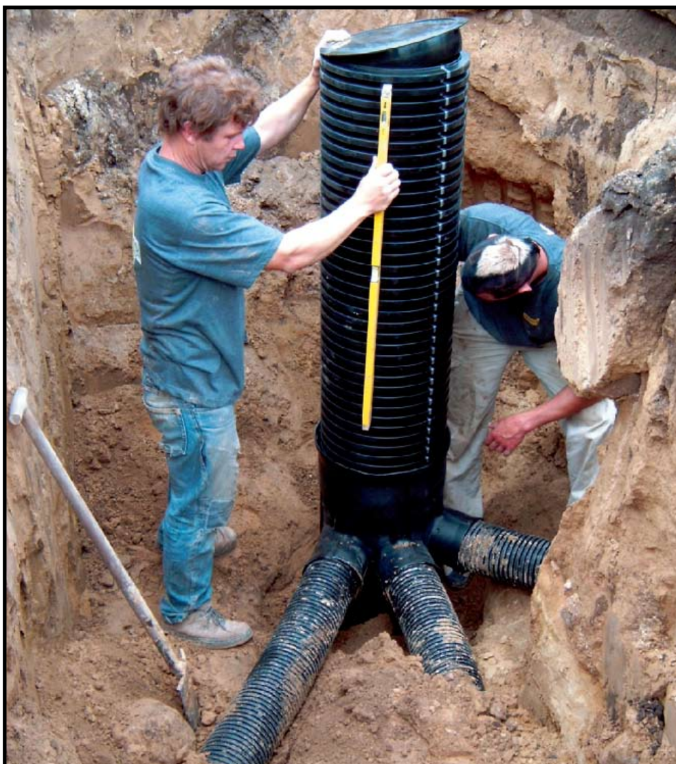
Plaatsing VENTERRA-SYSTEEM
